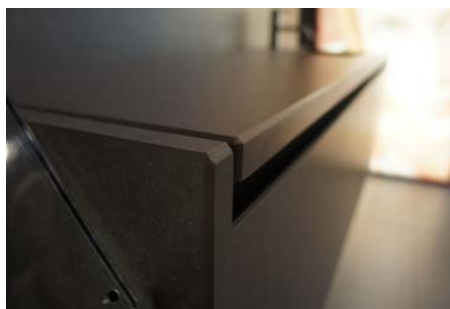
тип обработки кромки примыкания панелей "kerlit"
